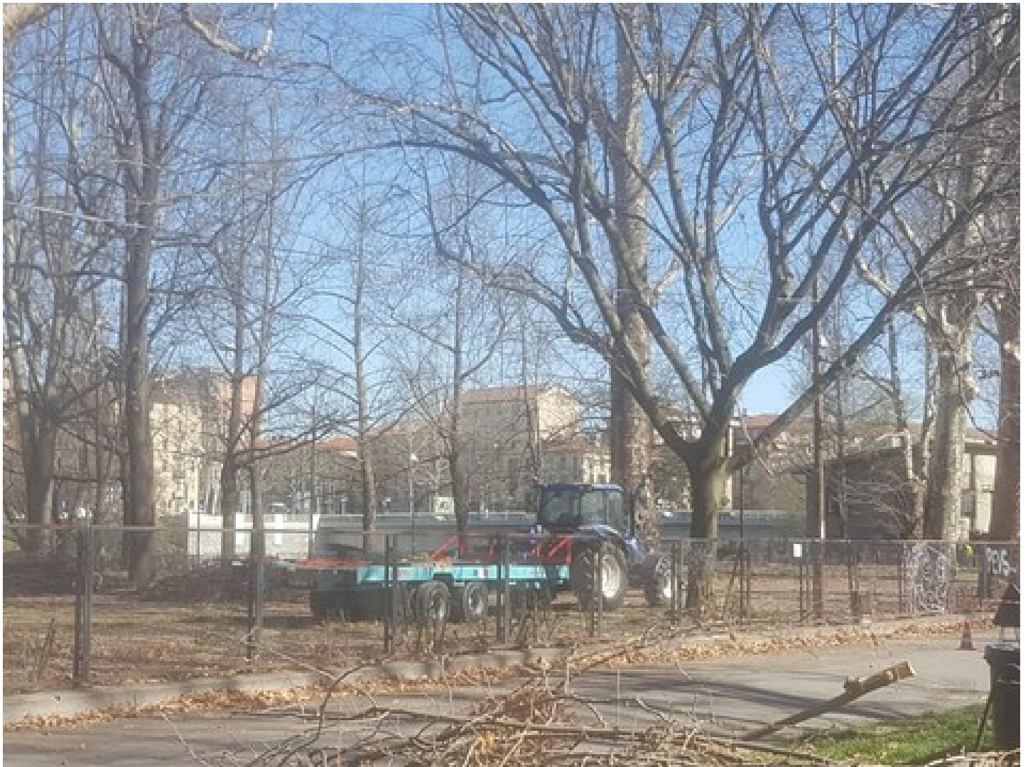
Nella foto, l'avvio dei lavori nella punta Nord, iniziati in inverno
